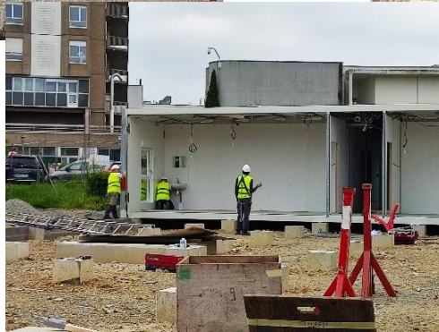
Photos du chantier prises entre le 23 mai et le 6 juin
